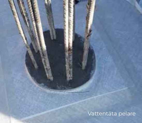
Installera membranet mot formen
