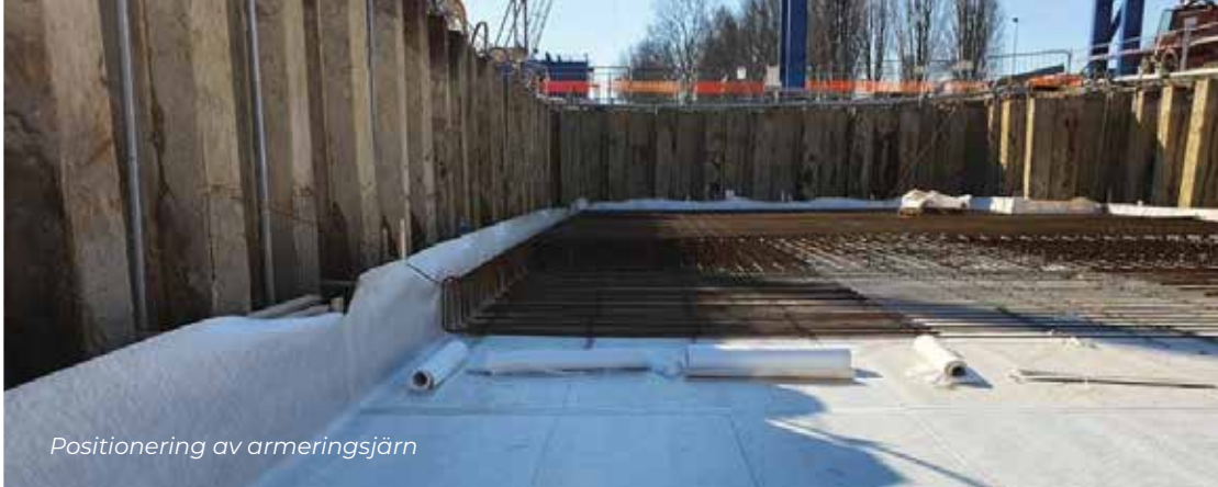
Exempel på plats med ett tätskitssystem
